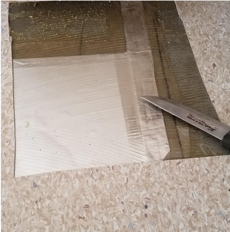
Kuva 12. D - siiven huoneesta maton alta paljastui alumiininen kalvo.
